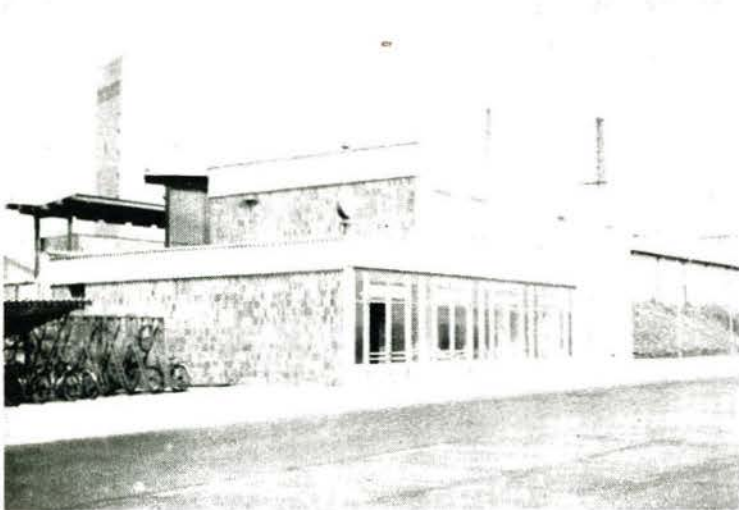
Bild 3 Das neue Empfangsgebäude Zielitz, im Hintergrund der neugeschaffene Kali-Betrieb
