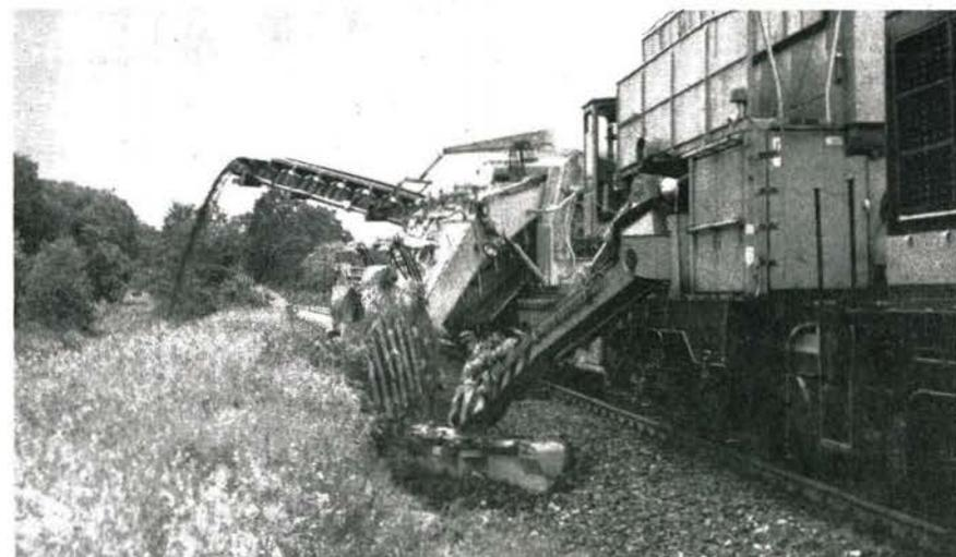
1 Weiterentwickelte Kleinstopfmachine der DR im Erprobungseinsatz auf dem Güterbahnhof Halle (Saale) im Jahre 1967 in Anwesenheit von Experten der ČSD
