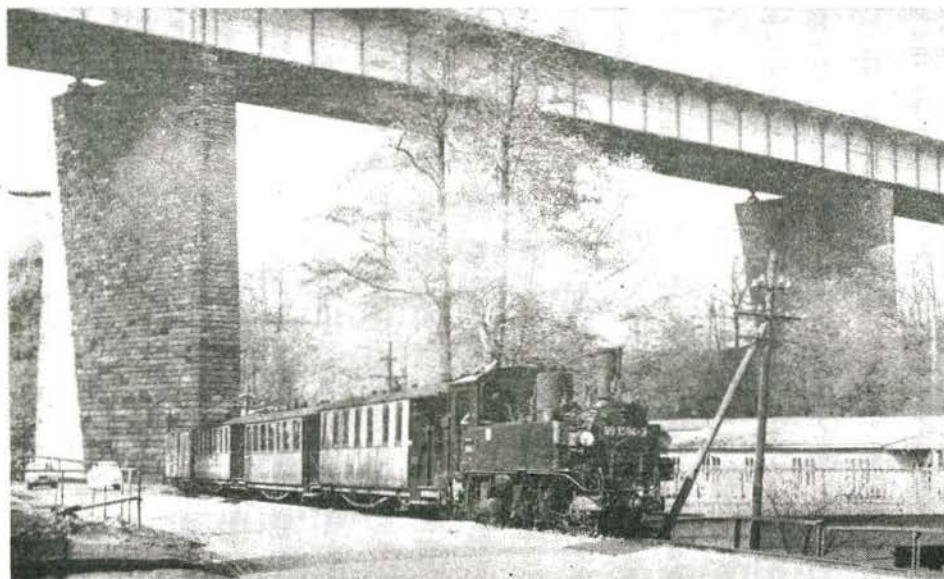
Bild 1 Strecke Wilkau-Haßlau—Kirchberg (Sachs) unter der Autobahnbrücke um 1968
