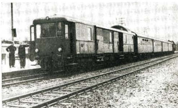
Bild 4 Als Befehlswagen eingerichteter Gepäckwagen, hier auf einer Versuchsfahrt mit Rekowagen.
