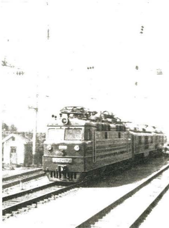
Bild 2 Ellok der Reihe „WL-60“ förderten zumeist unseren Zug zwischen Moskau und Nowosibirsk
