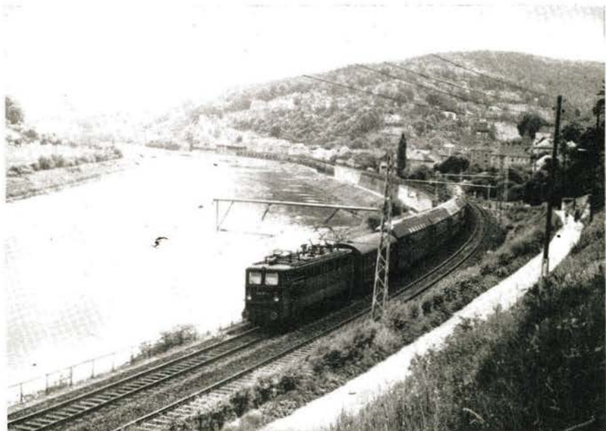
Bild 4 Blick auf einen Teil der umfangreichen Kunstbauten bei Königstein. Die Fahrleitung für das elbseitige Gleis wurde hier mit an den Masten des hangseitigen Gleises befestigt
