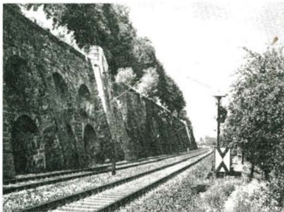
Bild 5 Unmittelbar nach Verengung des Elbtals hinter Pirna war auch hier eine Sonderkonstruktion für das Anbringen der Fahrleitung an den mächtigen Stützmauern notwendig
