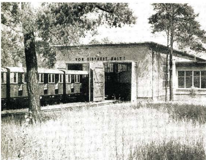
Bild 2 Die Wagenhalle des Bahnbetriebswerkes
