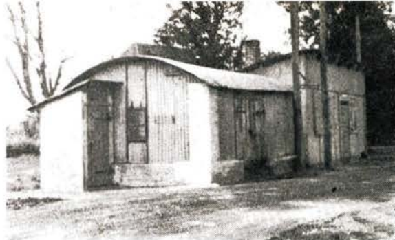
Bild 1 Dienstgebäude und Werkstattschuppen des Hp Trent. Dieser Haltepunkt ist durch einen Wärter besetzt, was nicht bei allen Haltepunkten der Fall ist.
