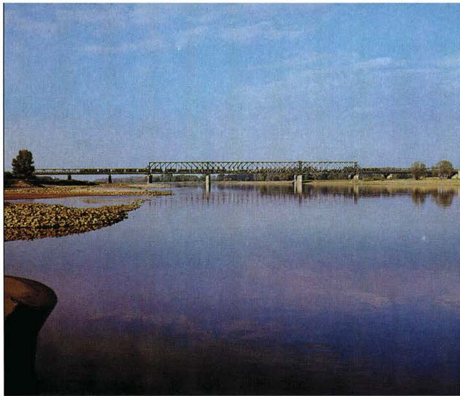
Lehrter Bahn: Elbübergang bei Hämerten
