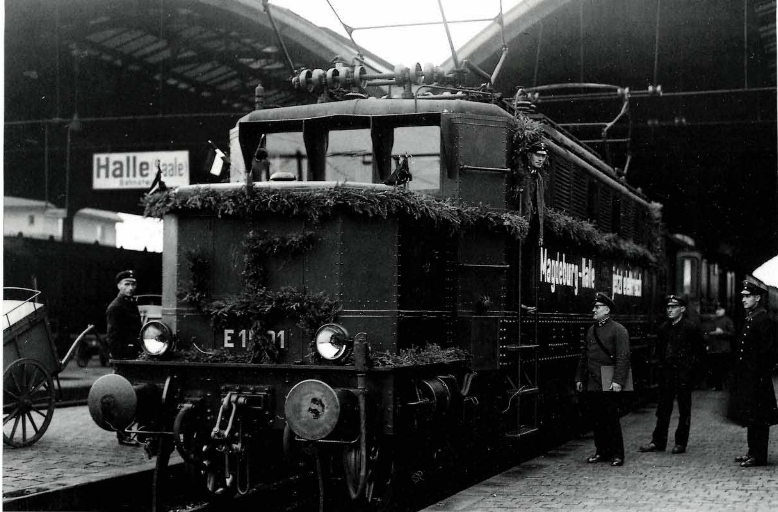
Bild 5: E 15 01 mit einem Personenzug nach Magdeburg in Halle (S) Hbf am 7. Oktober 1934 anlässlich der Eröffnung des elektrischen Betriebs auf der Strecke. Abb.: Sammlung Bázold
