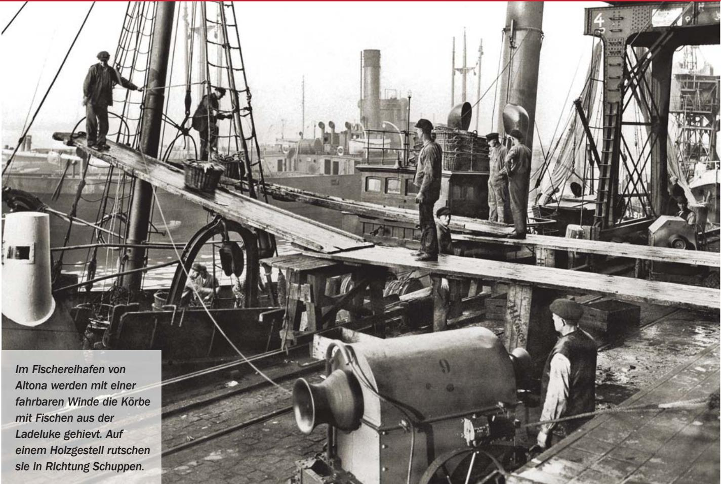
Im Fischereihafen von Altona werden mit einer fahrbaren Winde die Körbe mit Fischen aus der Ladeluke gehievt. Auf einem Holzgestell rutschen sie in Richtung Schuppen.
