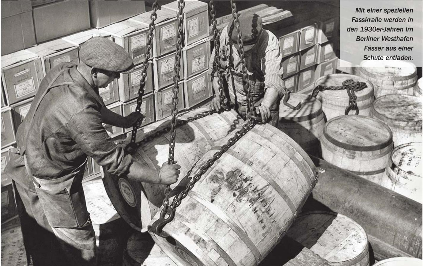
Mit einer speziellen Fasskralle werden in den 1930er-Jahren im Berliner Westhafen Fässer aus einer Schute entladen.
