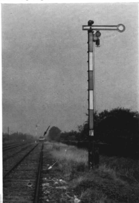
Abb. 1 und 2. Unmaßstäblicher Lageplan des Bf. Ofenerdiek mit dem „überflüssigen“ Signal (rechts). Der schwarze Pfeil (im Bild) weist auf den Prellbock hin, der weiße auf die „Indusi“. (Foto: J. Braun, Oldenburg)
