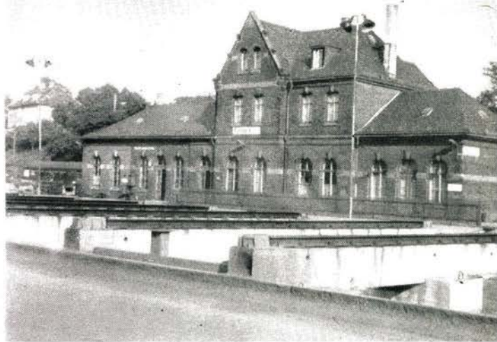
Bild 5 Blick auf das EG Pößneck unterer Bahnhof, im Vordergrund die Großverbundplatten-Umladeanlage für den Aufbau des Neubaugebiets Pößneck-Ost
