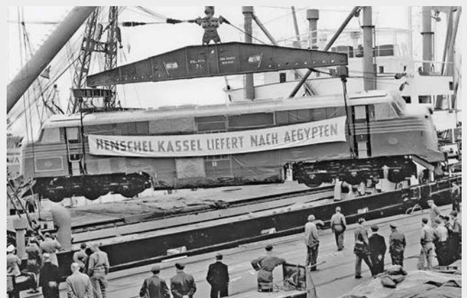
*Auf die internationale Anerkennung seiner Konstruktionen war man in Kassel immer stolz. 1954 wird eine Diesellok für die ägyptische Staatsbahn verschifft, die unter Lizenz von General Motors Electro-Motive Division von Henschel gebaut wurde* Archiv Henschel
