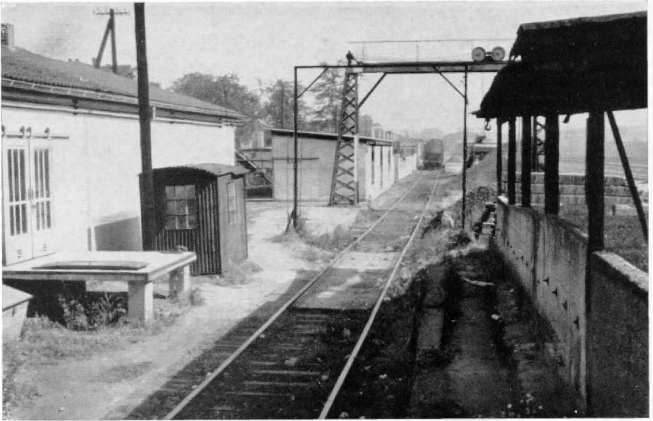
Abb. 8. Gleiswaage mit Wiegehäuschen, dahinter Lademaß und ein Bockkran auf dem Bahnhofsgelände von Würzburg (Foto Ertmer). — Abb. 9. Ein Wiegestand anderer Konstruktion mit Signal, der zweifelsohne interessanter aussieht als die Vorlage Tappert.
