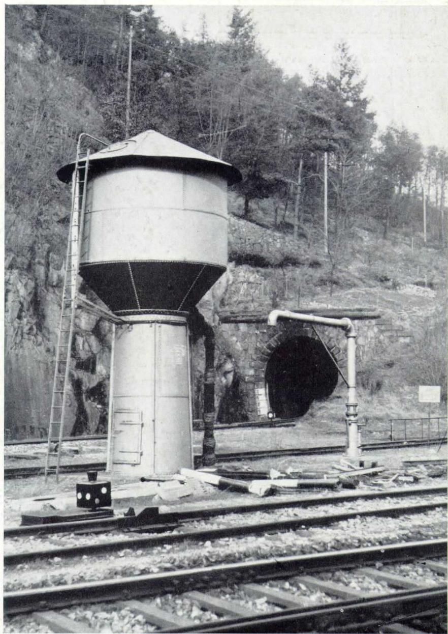
Ein netter kleiner Wasserturm am Bahnhof Schiltach/Schwarzwald. (Foto: H. A. Scheffler, Wiesbaden)
