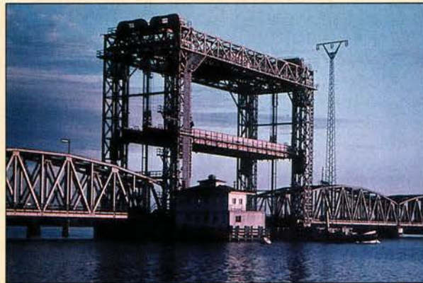
Von Usedom aus entstand 1940 dieses Bild von der Karniner Hubbrücke. Das Mittelteil wurde gerade angehoben.
