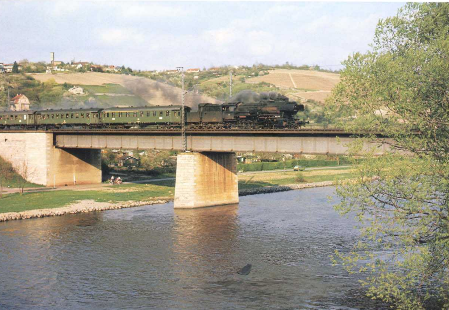
Bild 11: Eine Lokomotive der Baureihe 050 – 053 mit Kabinentender rollt mit dem P 5897 nach Lauda über die Mainbrücke bei Würzburg-Heidingsfeld. Hinter der Lokomotive sind ein Eilzugwagen 1./2. Klasse sowie zwei Eilzugwagen 2. Klasse zu erkennen. Alle Fotos: U. Geum
