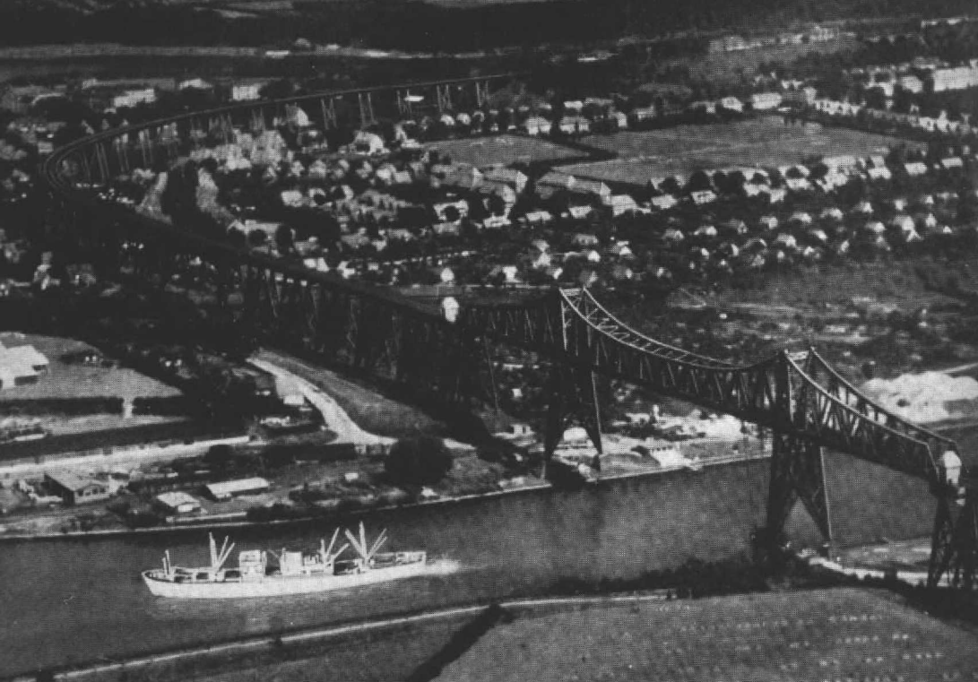
Abb. 6. Die Rendsburger Schleife (Luftaufnahme Schöning, Lübeck). Die Spannweite des Teils über dem Kanal beträgt 140 m, die Höhe 42 m, die gesamte Länge der Hochbrücke 2500 m. Die vom Verfasser auserwählten besonders charakteristischen Teilstücke sind gut erkennbar.
