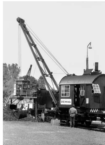
Auf einer zum Bauschuttplatz verkommenen Ecke des Museums-geländes entstand 2005 der „neue“ Kohlenhof. Der Demag-Kran von 1927 ist der letzte seiner Art, der sich selbst auf Schienen fortbewegt.
