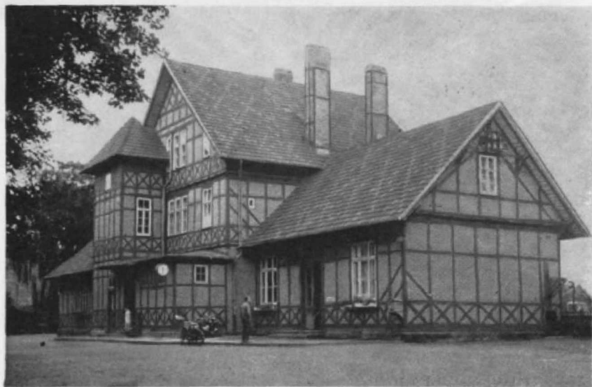
Abb. 1. Die Straßenseite des Empfangsgebäudes vom Bf. Bad Liebenstein/Thür., mit seinem Fachwerk und den Füllungen aus weißverputzten roten Backsteinen ein schmuckes Gebäude.
