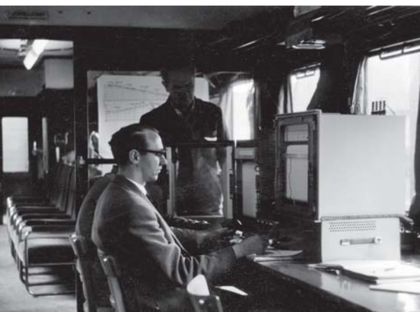
Bei den Probefahrten am Semmering und in Norddeutschland waren stets Messwagen in den Zügen eingereiht. Dort zeichneten analoge, elektromechanische Schreiber alle erforderlichen Daten auf.
