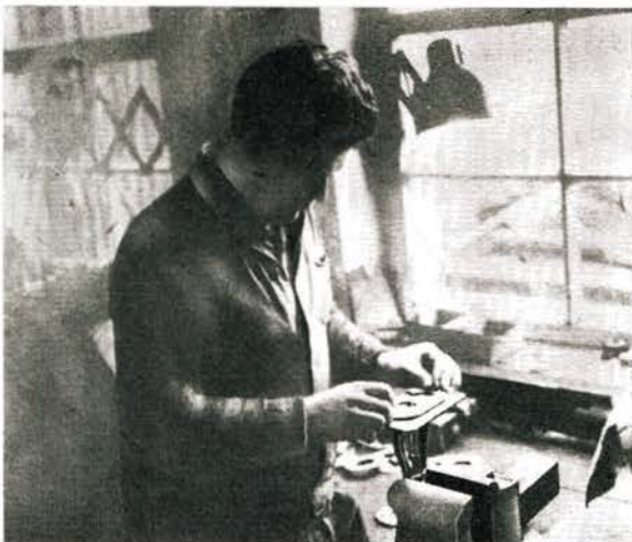
Zum Entgraten der Ziffern wird eine Handfräsmaschine mit biegsamer Welle benutzt. Kollege Ostermann bearbeitet gerade die innere Rundung der Ziffer 9 (oder auch 6) mit dieser Maschine
