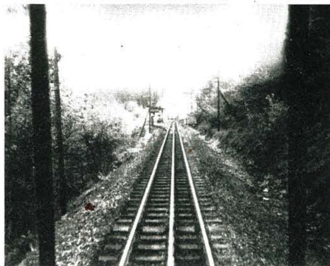
Bild 2 Blick auf den gemeinsamen Streckenabschnitt; im Mittelgrund ist das Stellwerk W 1 zu erkennen
