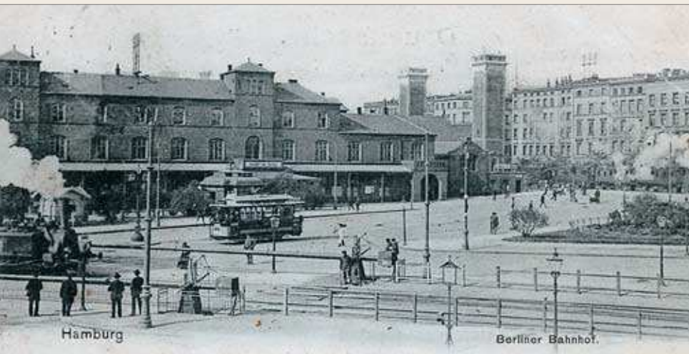
Links: Blick über die Verbindungsbahn auf den Berliner Bahnhof. Im Hintergrund ein Zug vom Venloer Bahnhof nach Altona. Foto: Sammlung Hermann Hoyer
