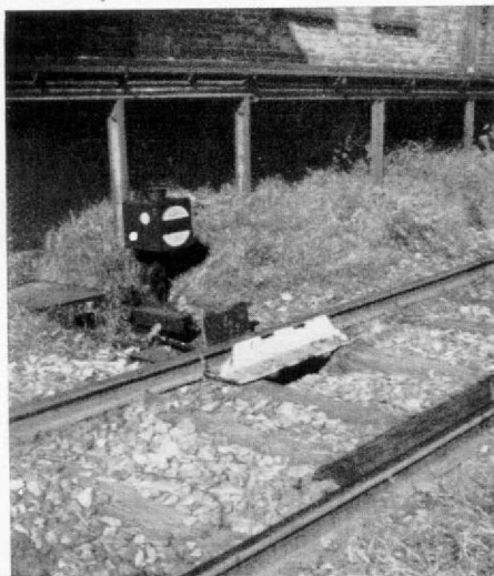
Abb. 1. Das Vorbild: eine Gleissperre (Rückansicht), bestehend aus Entgleisungsschuh und Sperrsignallaterne, links in Sperrstellung, rechts geöffnet, und . . .
