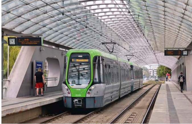
Hannover: Am Zweig der A-Strecke – hier die Station Noltemeyerbrücke – Richtung Altwarmbüchen entsteht ein neuer ÜSTRA-Betriebs Hof, da die Kapazität der bestehenden Depots erschöpft ist
