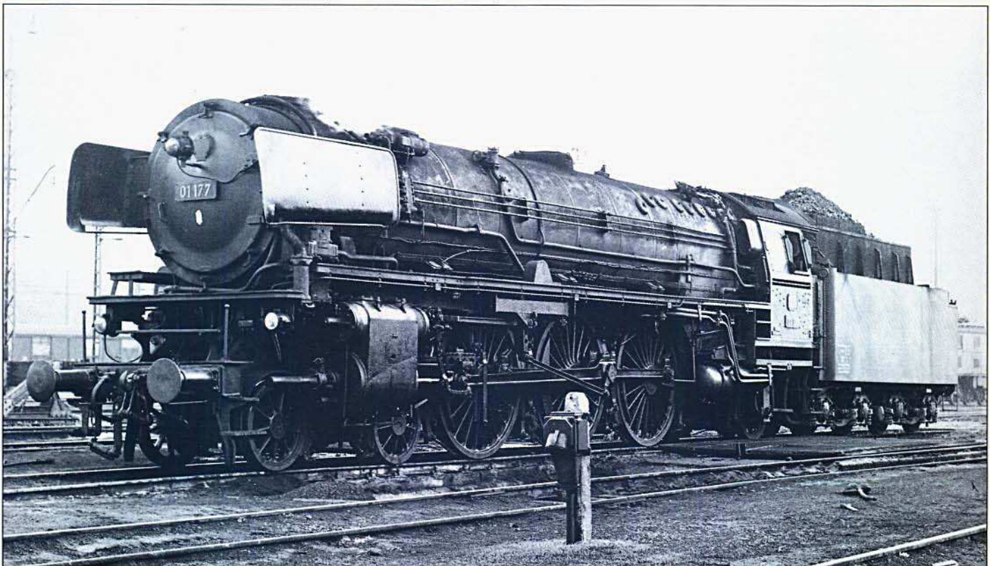
Bild 11: 01 177 mit DB-Neubaukessel und Ersatzzylindern. Abb.: H. Obermayer
