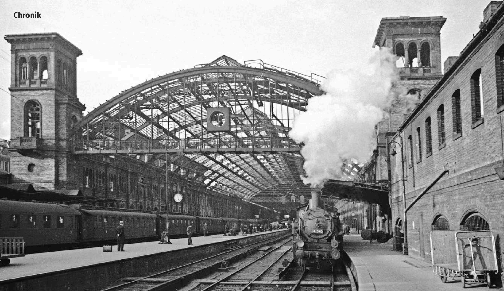
Vom Potsdamer Fernbahnhof stehen im März 1945 nach diversen Luftangriffen nur noch die Außenmauern und das Gerippe der Hallendachkonstruktion, aber es fahren Züge (Foto mit Lok 74 543). Kurz danach werden die Kriegsschäden so stark sein, dass die Reichsbahn den Betrieb einstellt
