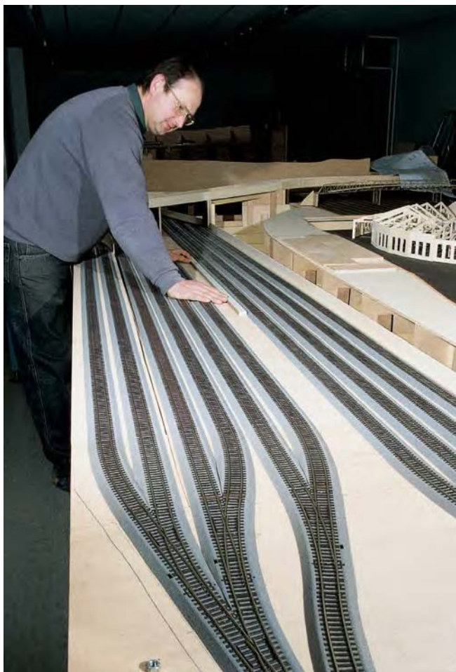
Links: Hinter den Kulissen – man erkennt die ungefähre Position des Ringlokschuppens – findet sich der große Schattenbahnhof, der für die Anlage Bamberg und Hof zugleich ist. Verbaut wurde hier RocoLine-Gleis mit Bettung, dessen dämmender Effekt hier für ruhige Zugfahrten sorgt.
