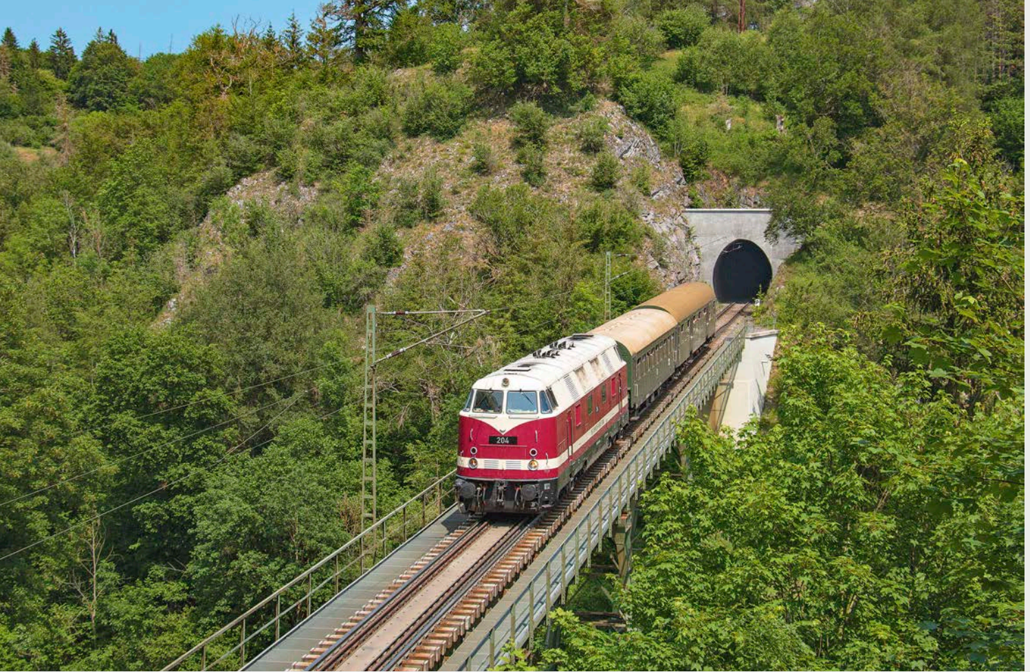
Am Nachmittag des 17. Juni 2023 rollt die Lok 204 über das 99 Meter lange und 29,16 Meter hohe Krockstein-Viadukt. Das im Volksmund als „Kreuztal-Viadukt“ bezeichnete Bauwerk ist heute das Wahrzeichen der Rübelandbahn
