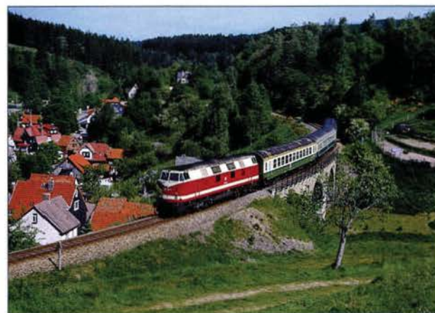
Am 31. Mai 1997 überquerte der Abschiedszug für die Strecke Suhl – Schleusingen das Hirschbacher Viadukt.
