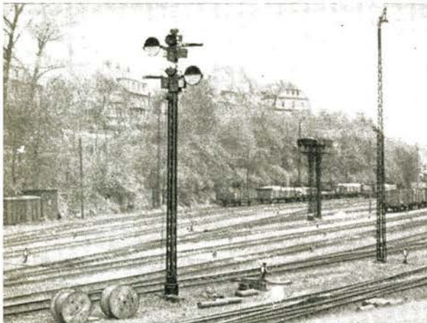
Bild 2 Räumungssignal im Bf Zittau; vier Scheiben an einem Mast, auf jeder Seite befindet sich eine Scheibe in Ruhestellung (1959)
