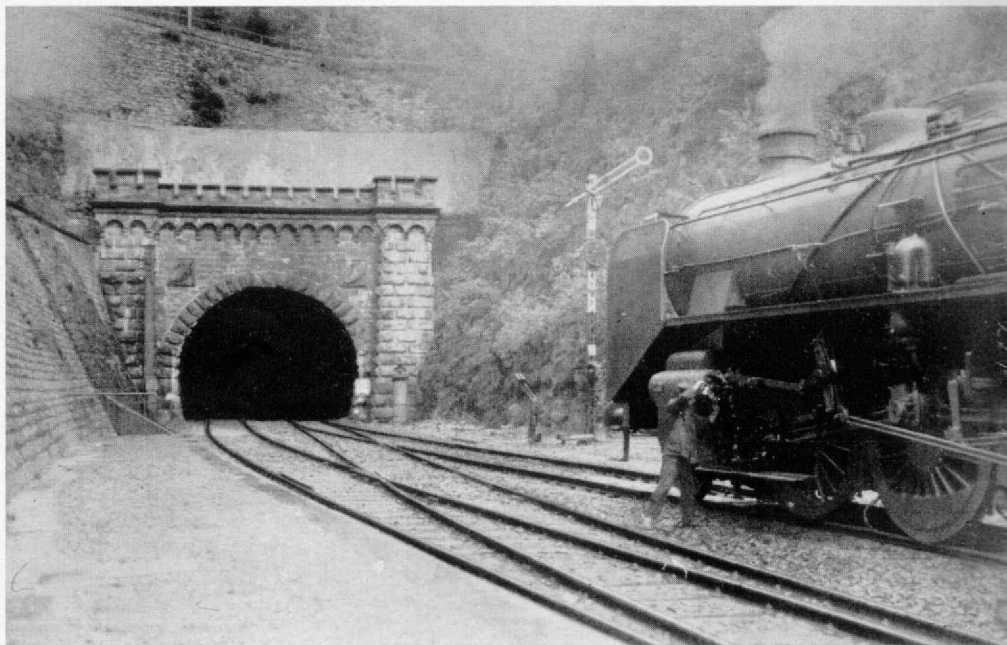
Die Einfahrt in den Brandleitetunnel (Bhf. Oberhof/Th.), der übrigens mit 3031 m Länge einer der längsten in Deutschland ist. Was uns aber heute interessiert — in Verbindung mit nebenstehendem Artikel — ist die schräge Stützmauer am linken Bildrand. Foto: Bellingrodt.
