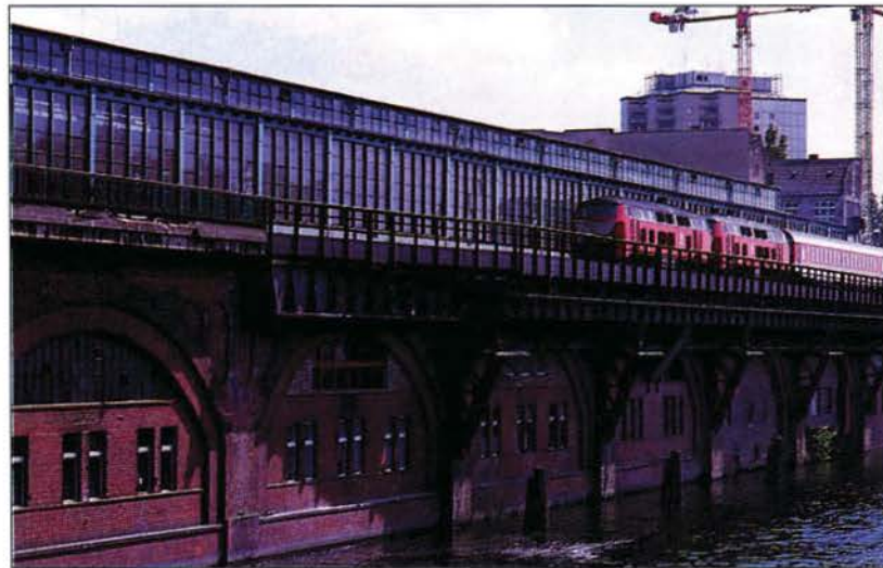
Belastungen: In den Spitzenzeiten begegnen sich jede Minute zwei S-Bahnzüge (Spreebogen; unten); die beiden Diesellokomotiven (Jannowitzbrücke; oben) wiegen zusammen 160 Tonnen.
