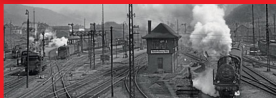
Vor 60 Jahren wurde er verlegt Heidelberg Hauptbahnhof
