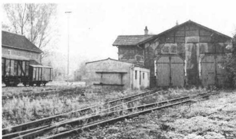
Bild 7: Der zweistöckige Lokschuppen in Ochsenhausen läßt noch in Ansätzen die Fachwerkstruktur erkennen. Foto: Obermayer
