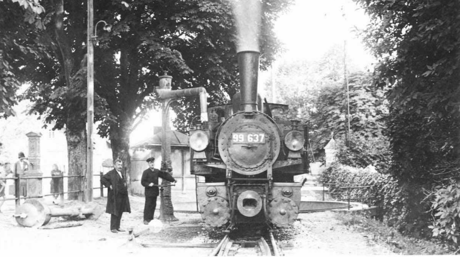
Bild 1: Als das Ochsenhauser Bähnle noch bis Biberach fuhr, befand sich an der Westseite des Biberacher Bahnhofs diese Drehscheibe mit Wasserkran, wo die Lokomotiven gedreht wurden. Heute ist die Stelle kaum noch zu erkennen, sie befindet sich unmittelbar hinter einem Zeitungskiosk, dessen Vorgänger auf unserem Bild hinter dem Wasserkran sichtbar ist. Foto: H. Maey, Sammlung Dr. Scheingraber
