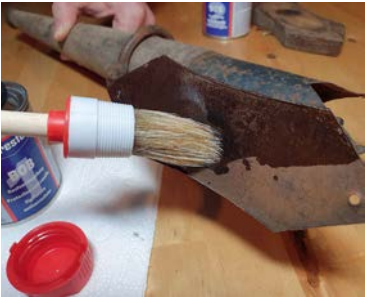
Die abgebürsteten und gesäuberten Flächen satt mit der Rostversiegelung einstreichen
