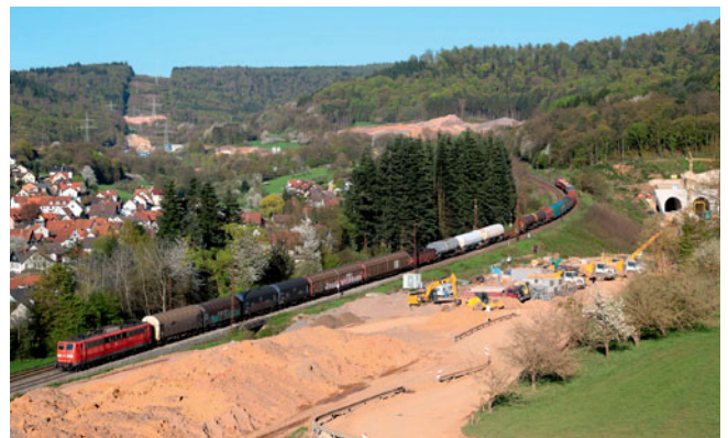
Ab 2017 fahren Güterzüge durch die Röhre rechts im Bild, der Schiebetrieb mit der Baureihe 151 ist dann wegen der deutlich geringeren Neigung nicht mehr notwendig. FOTO: MICHAEL MANN
