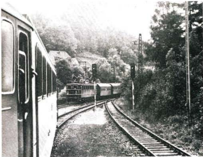
Bild 4 Lichtsignale im Bahnhof Rübeland
