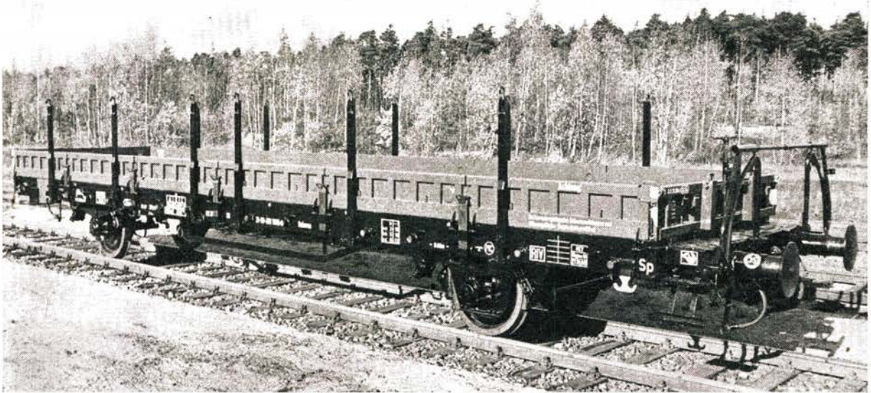
Bild 1 Zweiachsiger Flachwagen Typ Ralmms mit aufgesteckten Rungen
