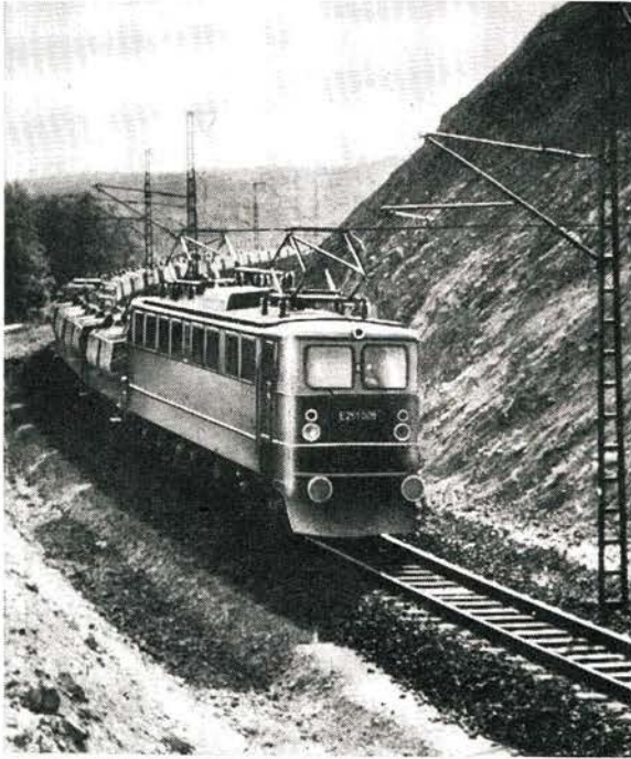
Bild 2 Güterzug im Einschnitt der Tunnelumgehung am Bliestein
