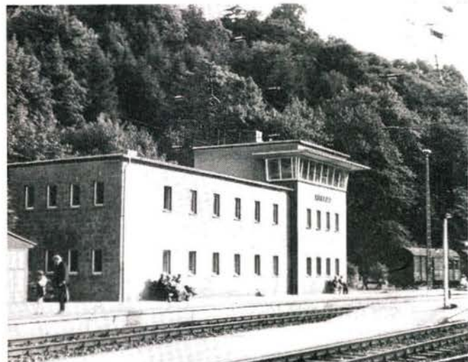
Bild 5 Das neue Gleisbildstellwerk auf Bahnhof Rübeland
