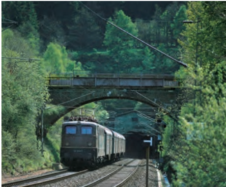
36 Am Rudersdorfer Tunnel Bahngeschichte(n)
