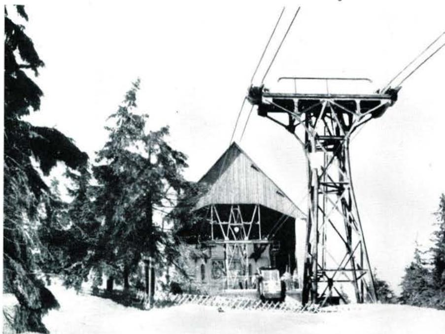
Bild 1 Blick in Richtung Oberwiesenthal. Im Vordergrund Stütze 2, die 552 m von der im Tale liegenden Stütze 1 entfernt ist.
