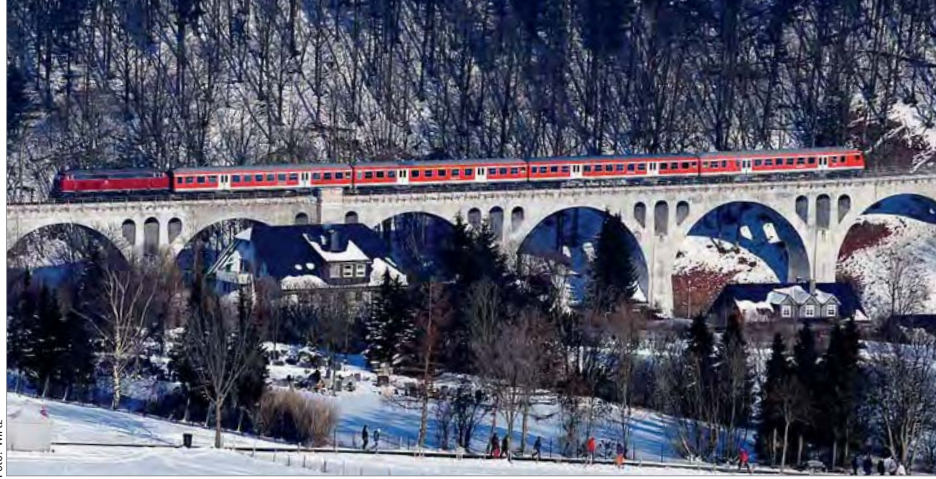
218387 der Kurhessenbahn überquert mit der Regionalbahn Korbach – Brilon Stadt den Willinger Viadukt.
