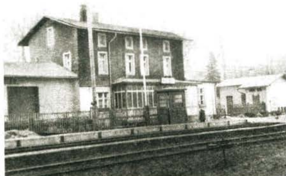
Bild 2 Ansicht des EG, von der Gleisseite aus gesehen
