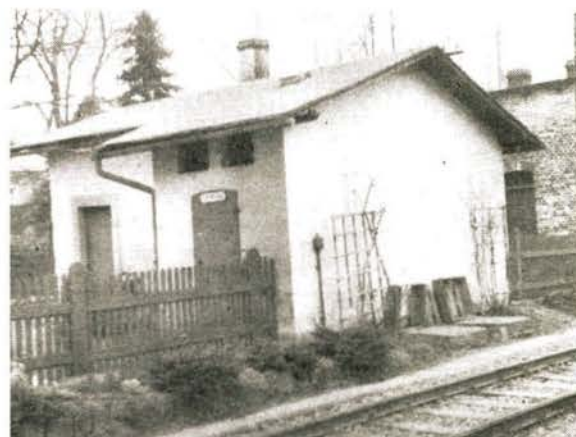
Bild 7 Abortgebäude, ebenfalls vom Gleis aus gesehen
