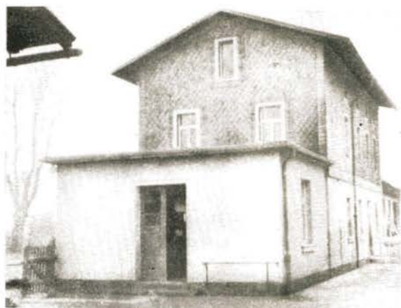
Bild 4 Ansicht des EG mit Warteraumanbau
