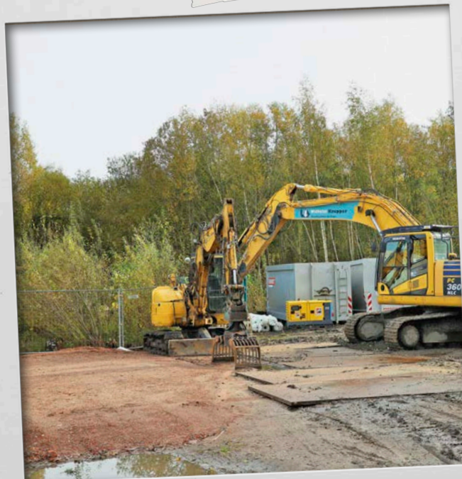
Am 30. Oktober 2023 ist die ehemalige Lokleitung des Bw Rheine bereits dem Erdboden gleichgemacht. Die Abrissbagger stehen vor dem zugewucherten Lokschuppen (links hinten)
