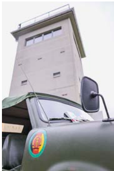
Ein Trabant der früheren Nationalen Volksarmee (NVA) steht vor dem frisch sanierten Grenzturm Heinersgrün
