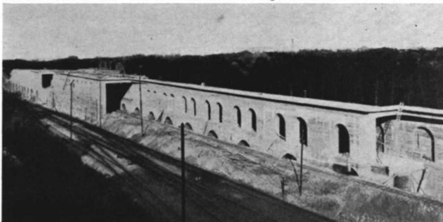
Abb. 49. Ein Teil des Dammbauwerks während der seinerzeitigen Bauarbeiten.
