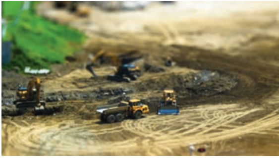
„Tilt Shift Construction“ oder eine Baustelle wie aus der Modellbahnwelt.
