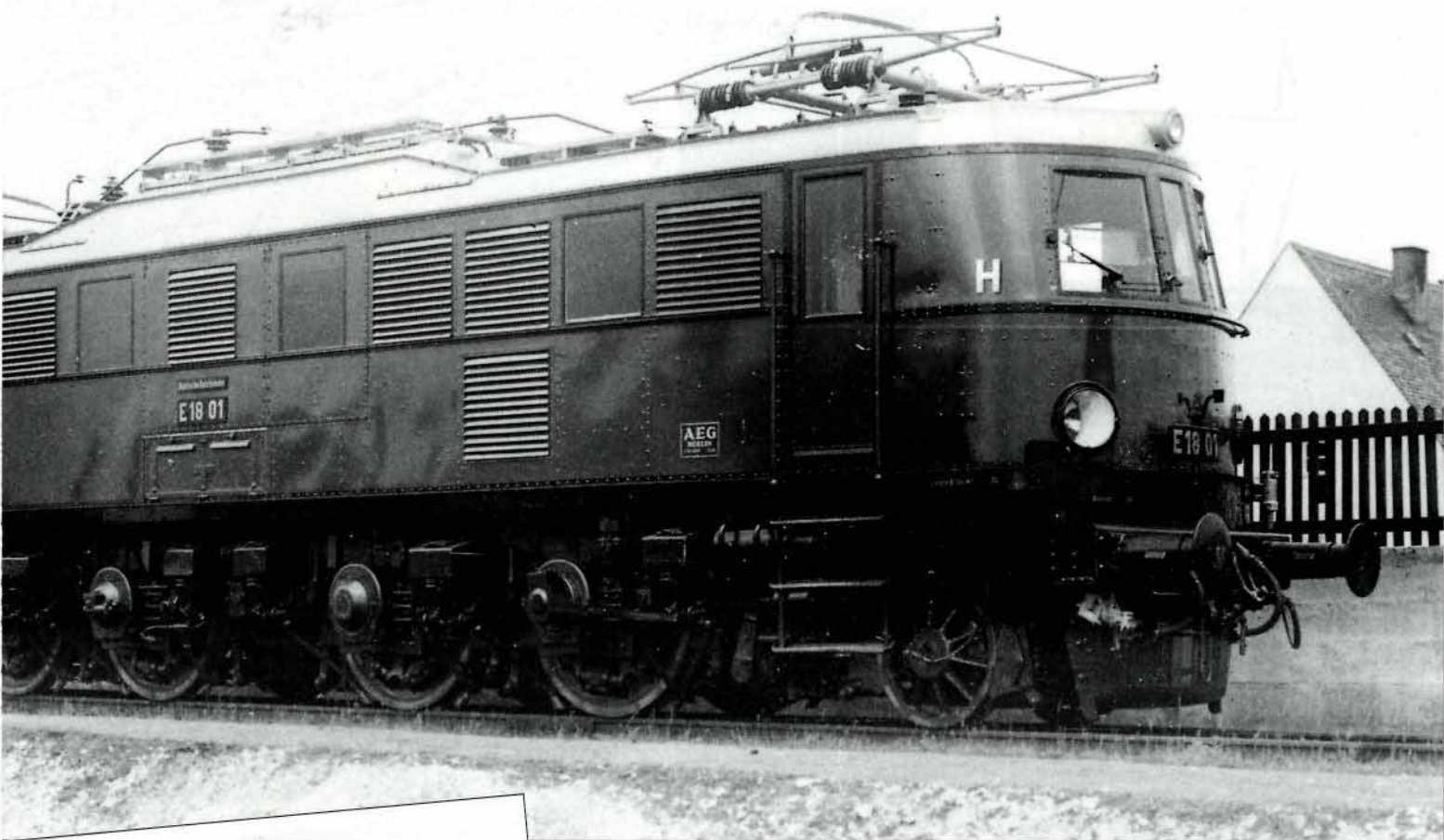
Bild 7: Am 16. Juni 1938 präsentiert sich die E 18 01 mit stirnseitigen Handstangen, kleinen Schürzen und tiefer angemalten Führerstandsbezeichnungen "V" und "H" im Raw München-Freimann. Foto: Sammlung Dr. Scheingraber
