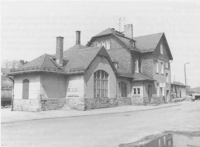
Bild 3. Fast 80 Jahre später, am 2.5.1986 vom Verfasser fotografiert: Empfangsgebäude und Güterschuppen in Wurzbach von der Straßenseite. Im Raum mit dem großen Fenster befindet sich die Gaststätte.
